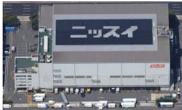
【日水物流(株)東京物流センター】 屋上に太陽光パネルを敷設し、 発電事業を開始
