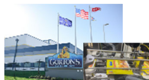
北米：新設工場 (26年下期：工場本格稼働)
