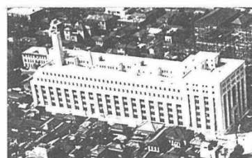
日産館 「日本水産」 本社は1937年8月、丸ビルより日産館に移転した
